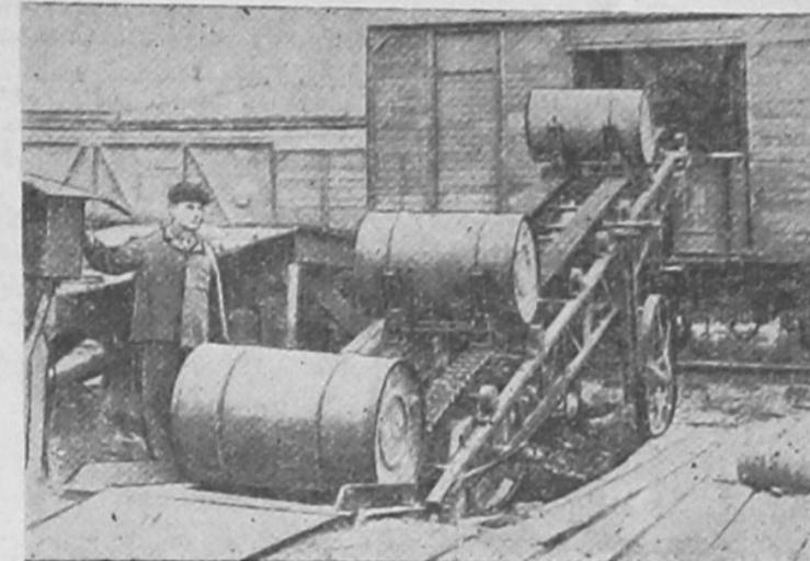
Слесарь-рационализатор масложиркомбината Павел Семенов разработал приспособление для погрузки бочек в вагоны. Сейчас этот механизм прочно вошел в производственный процесс комбината и намного ускорил и облегчил эту трудоемкую операцию. На снимке: механизированная погрузка бочек в вагоны.
